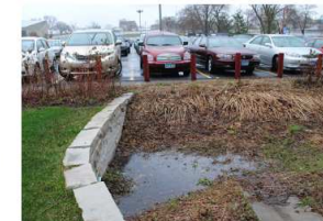
Regnbed som fanger opp overvann fra parkeringsplass ved University of Minnesota, St.Paul, USA. Tønnet infiltrerer ned til grunnen mens forurensningen forblir i filtermediet.
