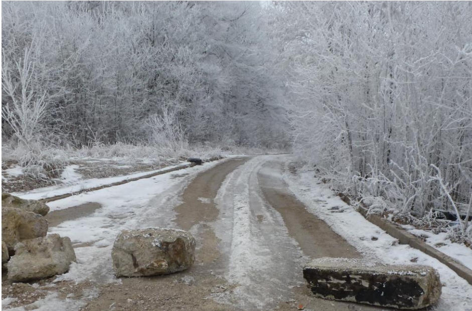
Úsek účelovej cesty medzi Budimírom a Košicami so zábranami vstupu pre motorové vozidlá.
