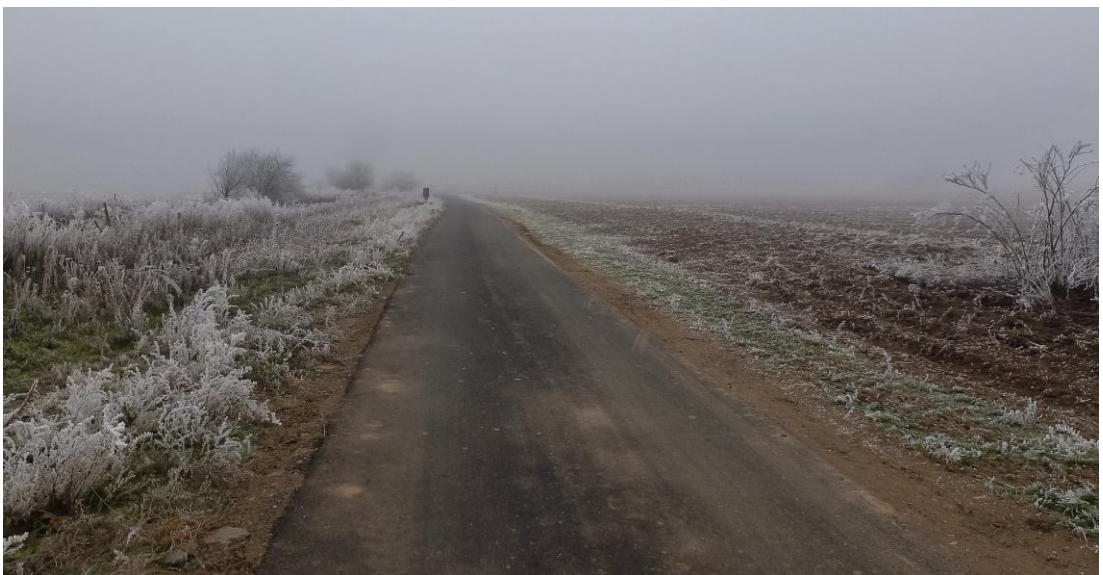
Úsek novovybudovanej účelovej komunikácie medzi obcami Čaňa a Gyňov.
