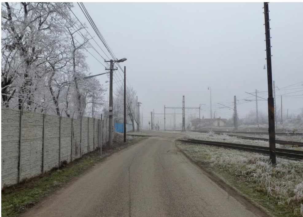
Čaňa – prejazd cez vlečku na účelovej komunikácii vedúcej k jazeru Tajvan popri žel.trati
