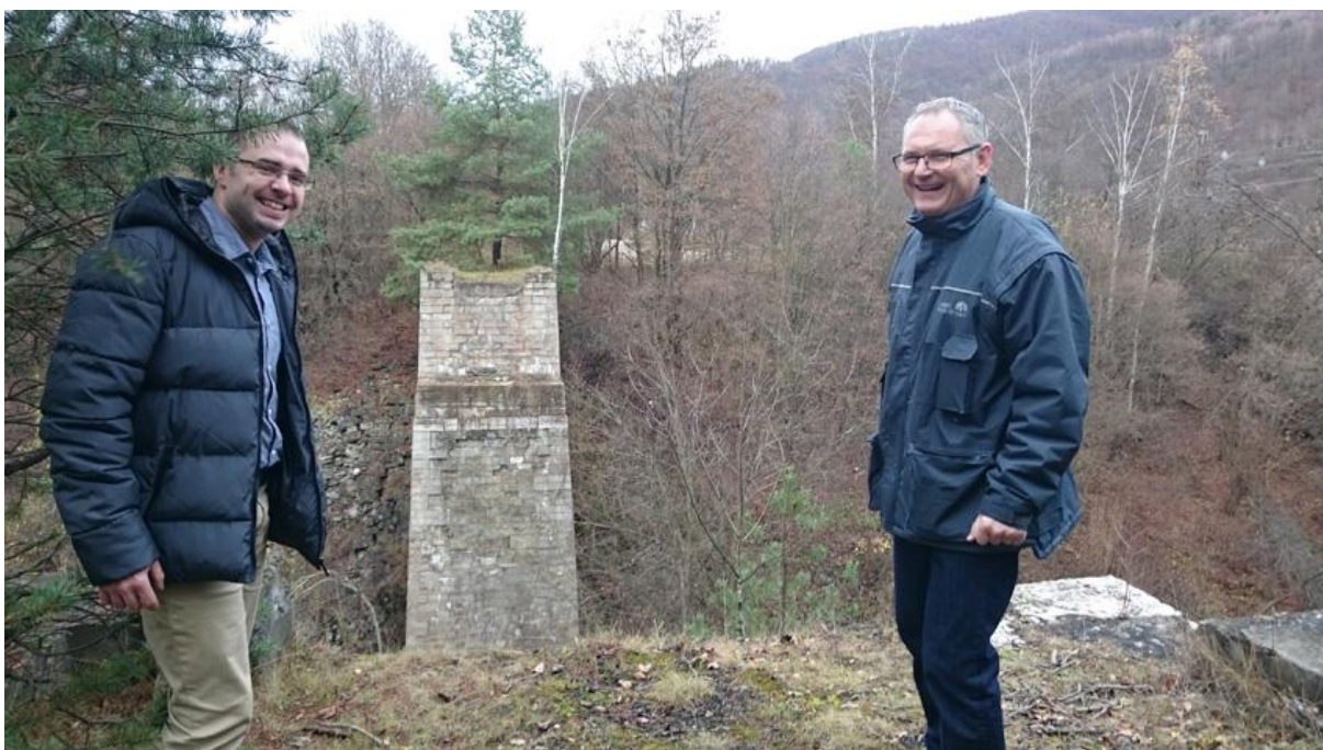
Koniec železničného zvršku pri pilieroch po železničnom moste cez Hornád.
