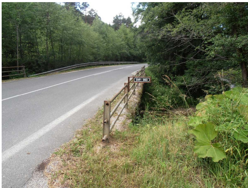
Vozovka na moste - pravá rímsa
