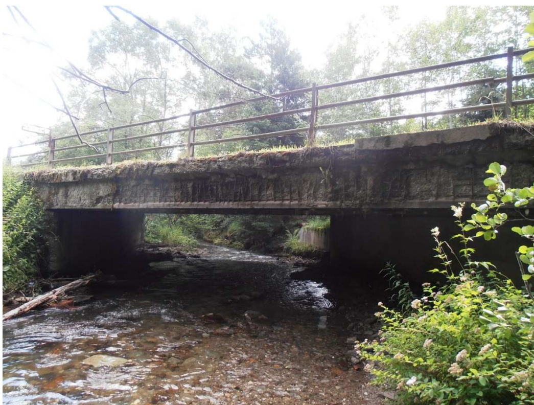
Pohľad na nosník
