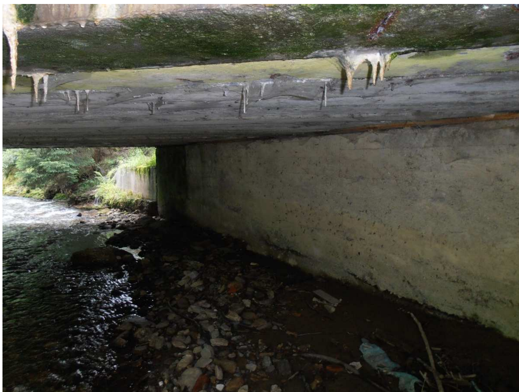
Pohľad na oporu 2
