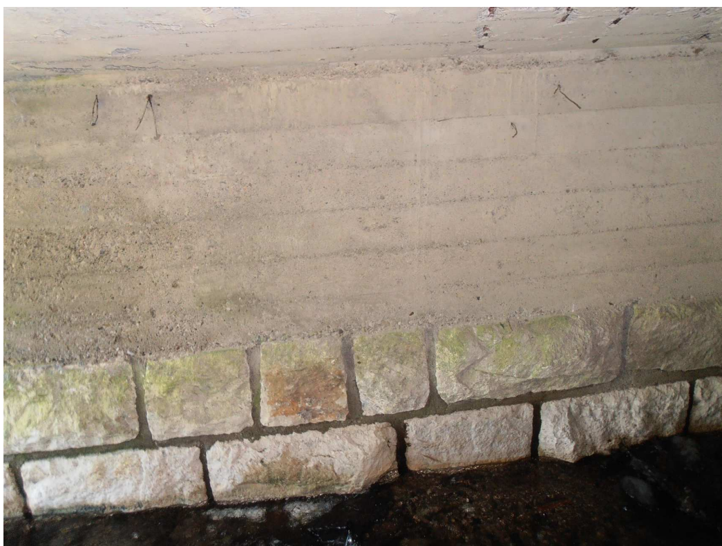
Pohľad na oporu č. 2
