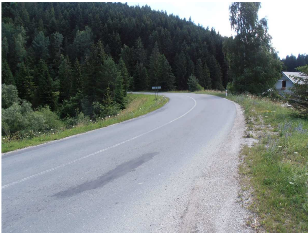
Vozovka na moste
