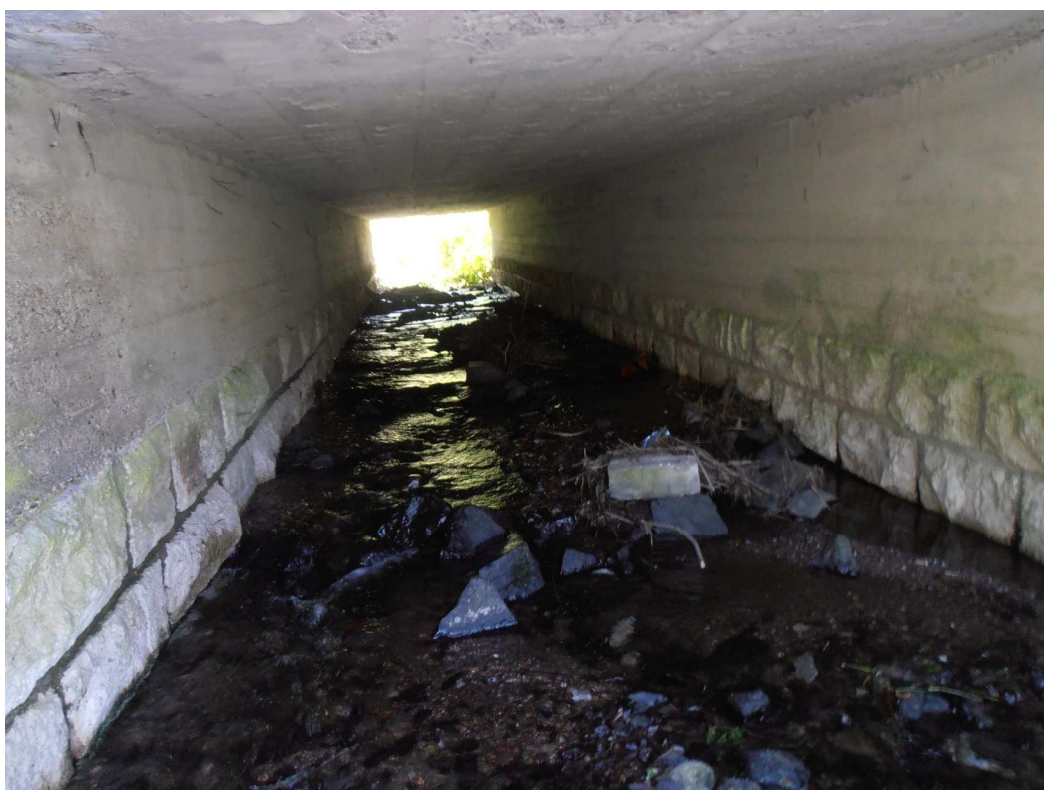
Pohľad pod most
