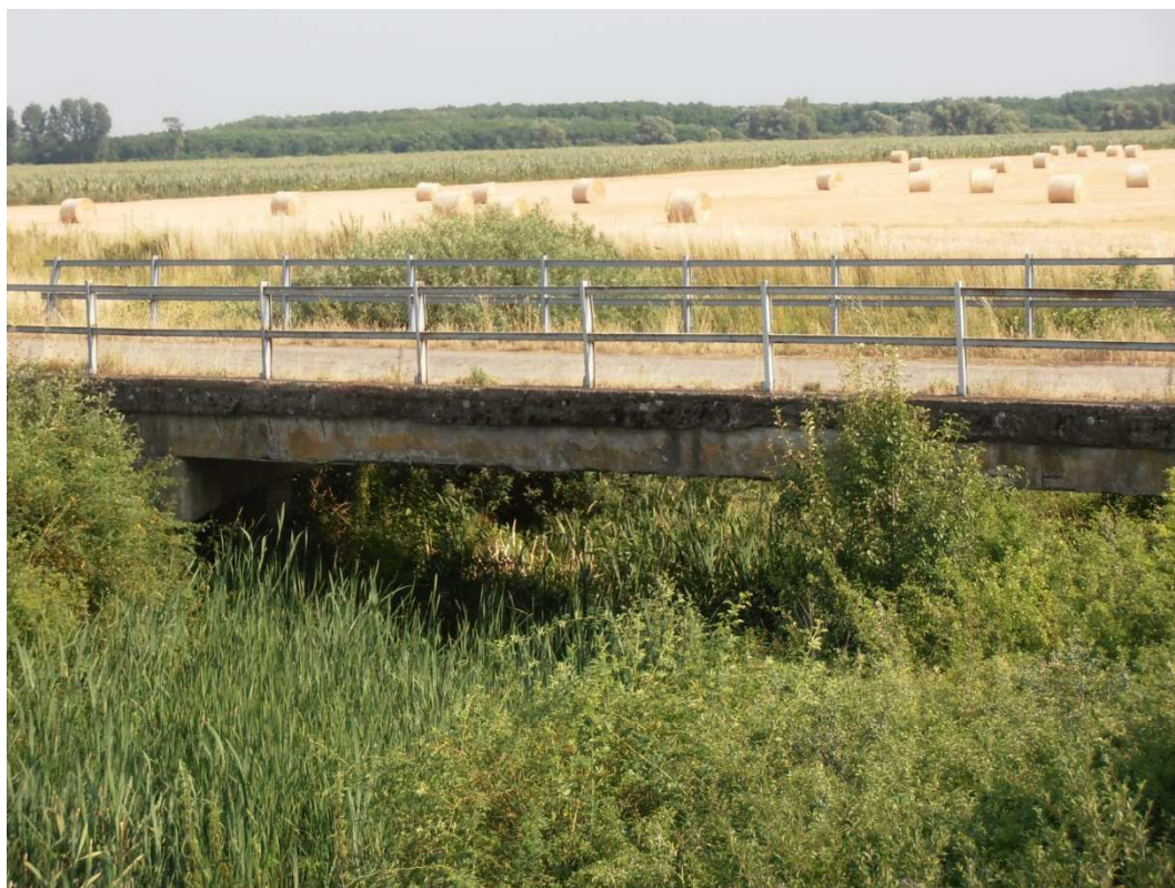
Pohľad na most
