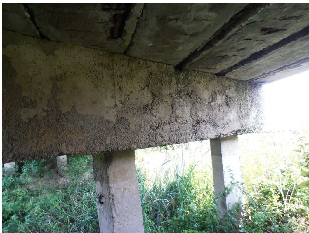
Úložný prah piliera č. 3
