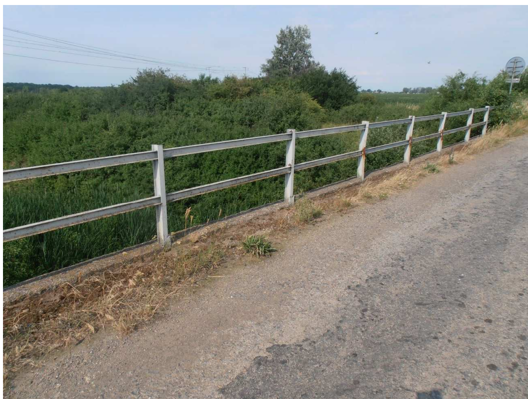
Vozovka na moste, rímsa, zábradlie, uchytená vegetácia
