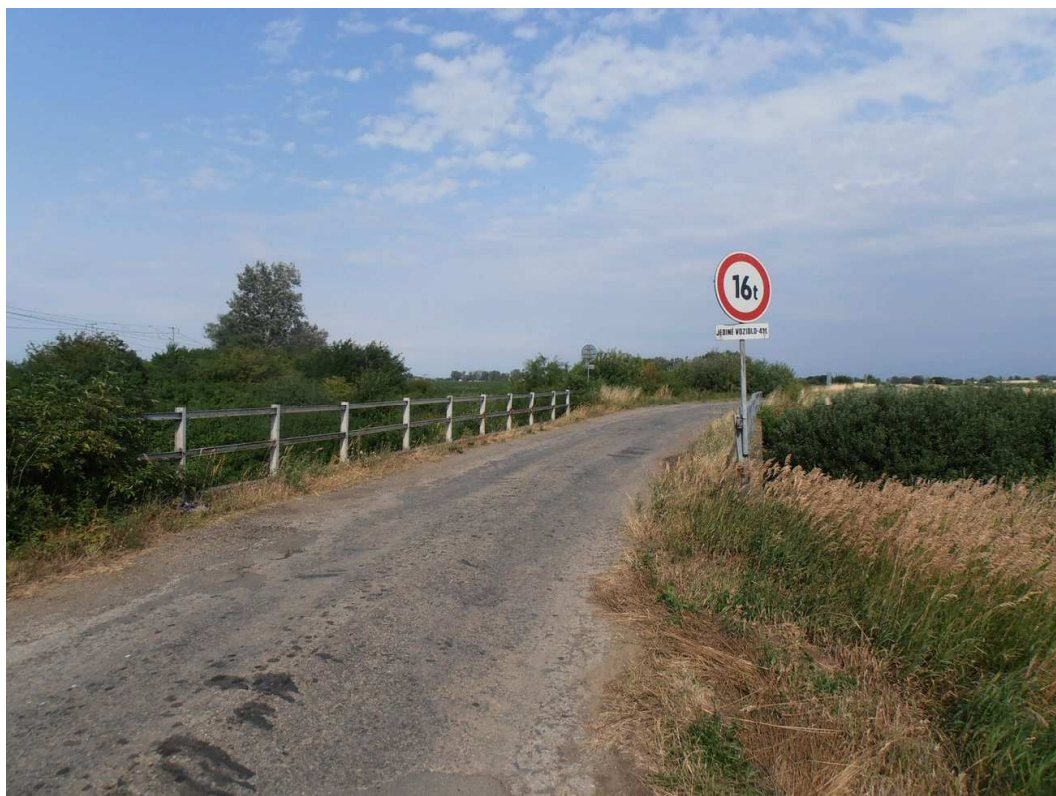
Vozovka na moste
