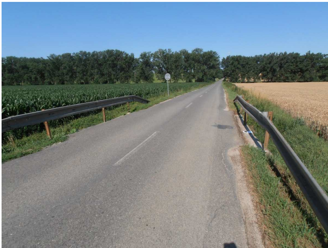
Vozovka na moste
