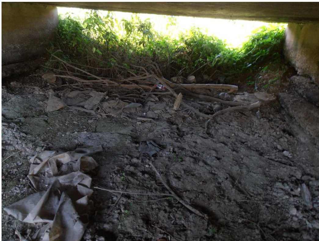
Pohľad na priestor pod mostom
