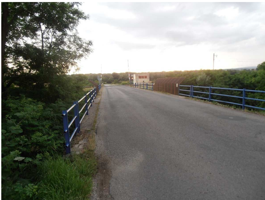
Vozovka na moste
