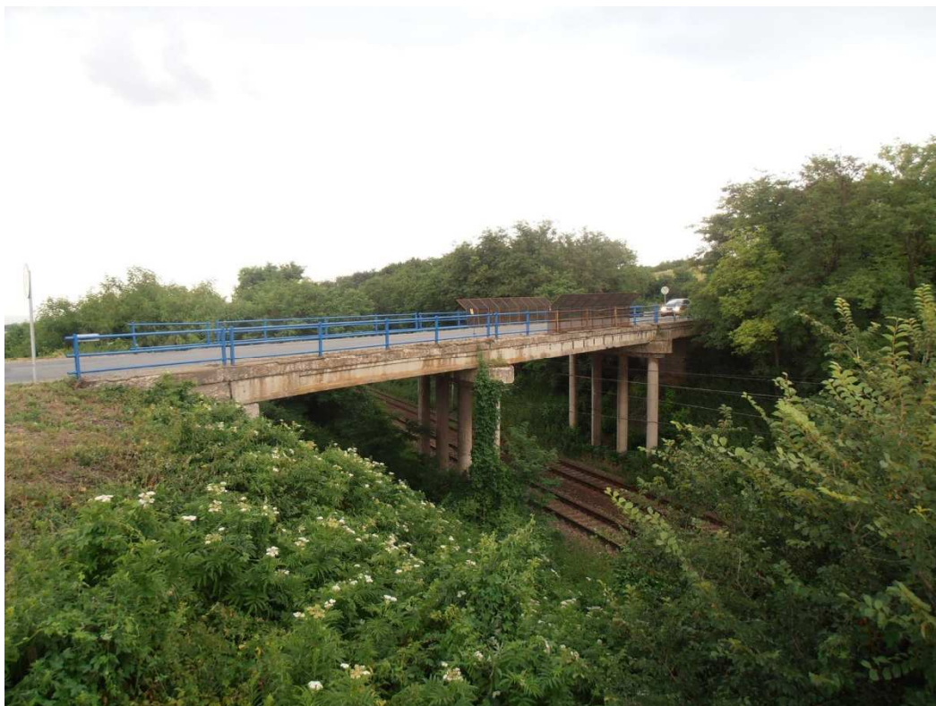
Pohľad na most
