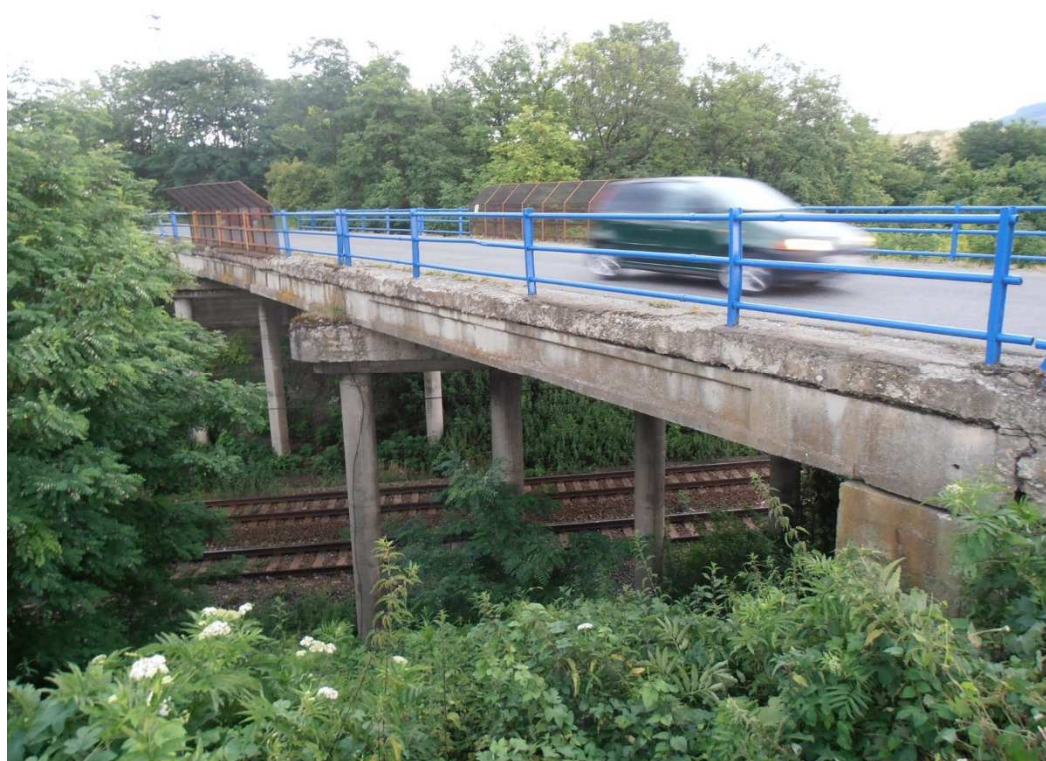
Vozovka na moste, rímsa, zábradlie, ochranná sieť
