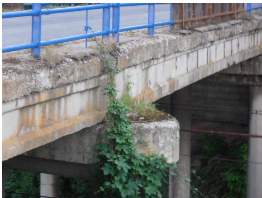
Znečistený UP piliera
