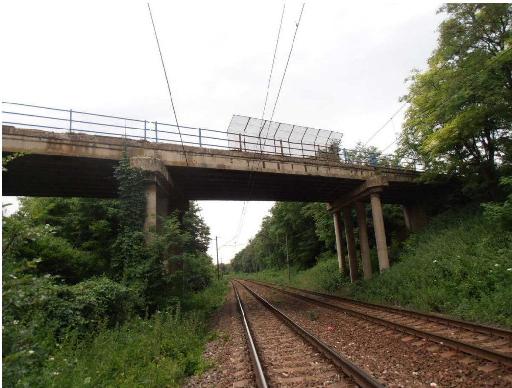
Pohľad na most
