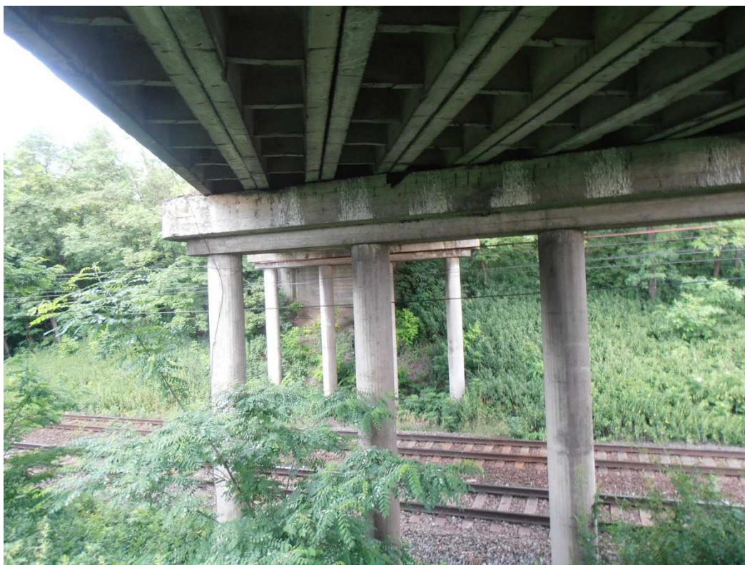
Priestor pod mostom, spodná stavba
