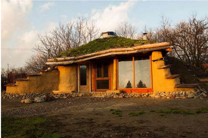
Obr. 8 Hobití dom postavený technikou Earthbags – Družstevná pri Hornáde
