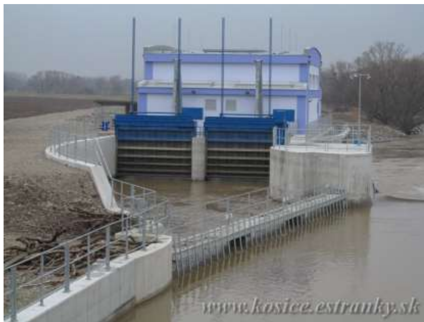
Malá vodná elektrárň na rieke Hornád, Ždaňa ( http://www.kosice.estranky.sk/clanky/vystavba/projekty---priemyselne/elektraren---zdana.html )
