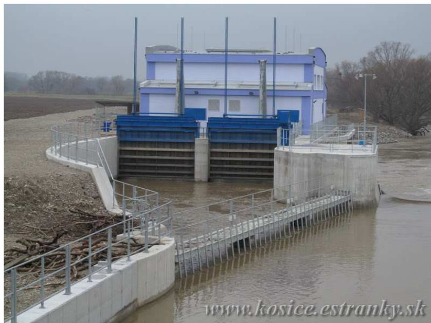
Obr. 28 Malá vodná elektrárňa na rieke Hornád, Ždaňa ( http://www.kosice.estranky.sk/clanky/vystavba/projekty---priemyselne/elektraren---zdana.html )
