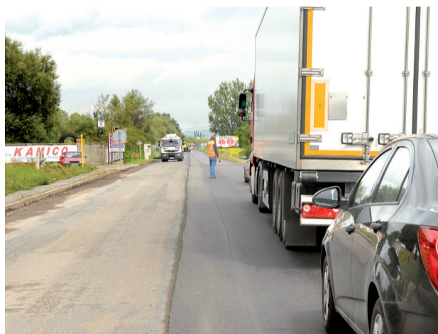
Poškodených je okolo 80-tisíc štvorákov Kraj prioritne opravuje najfrekventovanejšie a najnebezpečnejšie úseky ciest. FOTO:VERONIKA JANUŠKOVÁ
