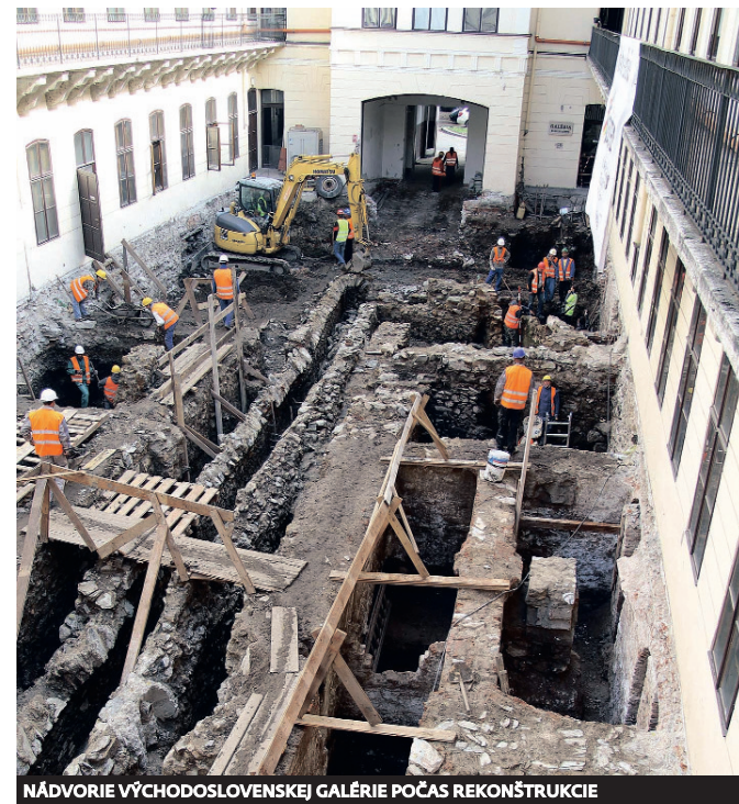
NÁDVORIE VÝCHODOSLOVENSKEJ GALÉRIE POČAS REKONŠTRUKCIE
