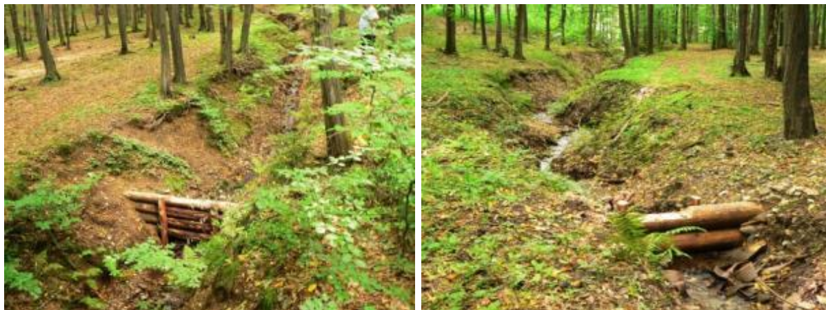
Vodozádržné opatrenia v katastri obce Gočovo, zrealizované v roku 2011
