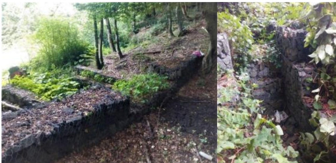
Postavené gabióny v Čermeľskom údolí a nad Ťahanovcami zrealizované 2005, Foto z r. 2020
