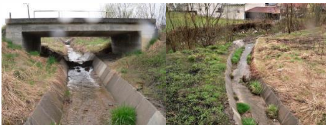
Uplatňovanie starej vodnej paradigmy na čo najrýchlejší odtok povodňovej vody do rieky Hornádu prispieva k zanášanju priehradu Ružín
