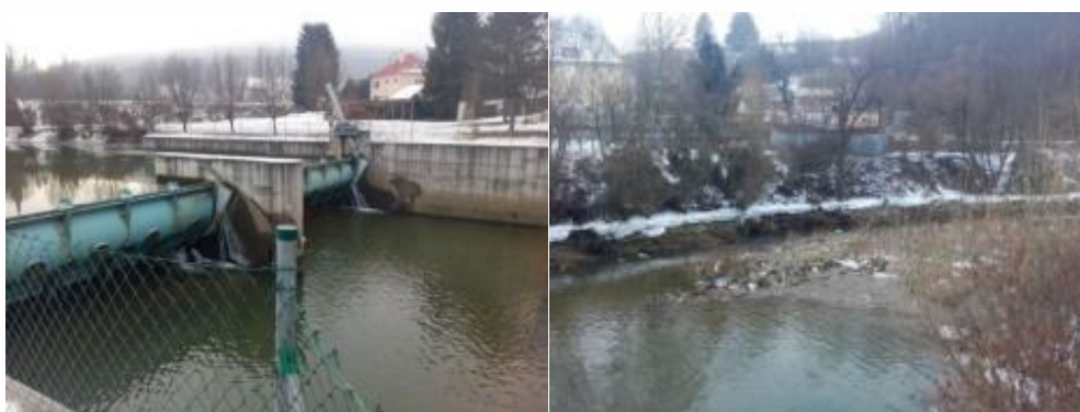
Poškodenie krajiny povodí prispieva k znižovaniu energetického potenciálu vodných tokov, k povodniam, k poklesu minimálnych prietokov (Prakovce, 2019)
