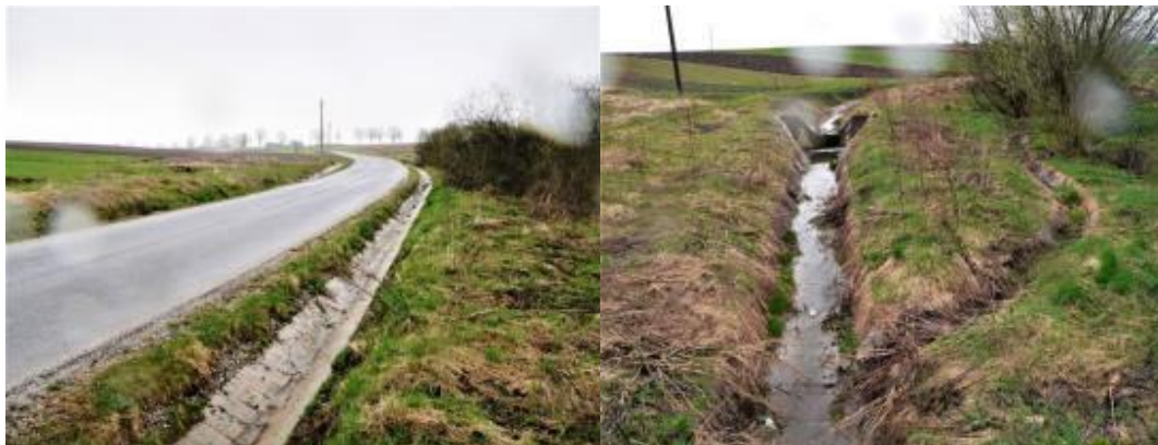
Každý kanálik v povodí Hornádu pomáha rýchle plnenie povodňovou vodou a sedimentmi priehradu Ružín (2015)
