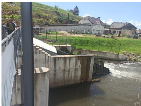
Obr. č. 2, 3,4,5: Malá vodná elektrárň v Čoltove, Archimedova skrutka. Vlastníkom je konateľ spoločnosti Kraft. s.r.o., Csaba Kozsár, ktorý odborníkom rozpráva o fungovaní MVE.
