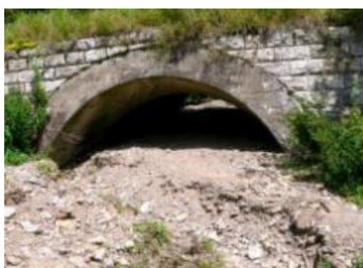
Železničný priepust pred Bujanovským tunelom zasypaný štrkom z erózne činnosti v lesoch (2010)
